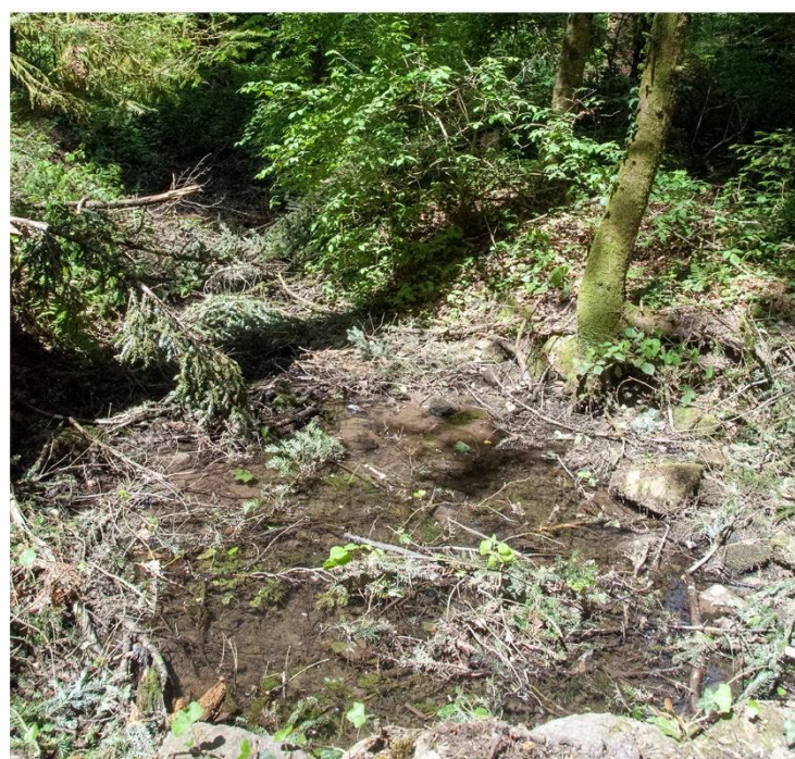
Fig. 5 : Le ruisseau de Pra Chermin (conduites de canalisation, vue du haut — sous en pont, vue du bas).
