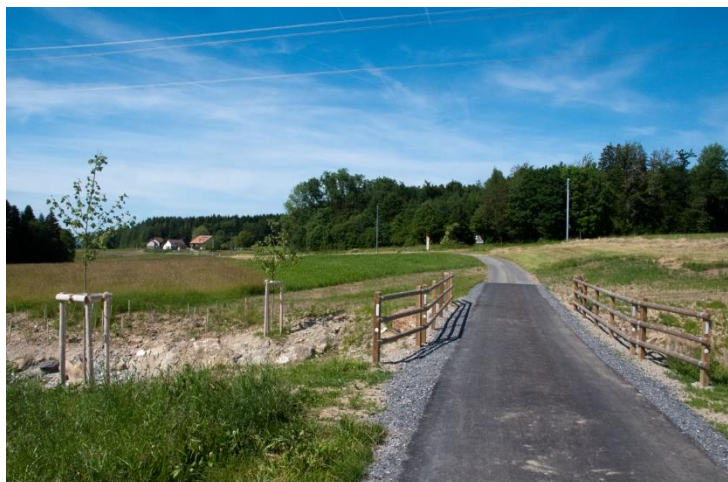
Ponceau du chemin de la Goletta
