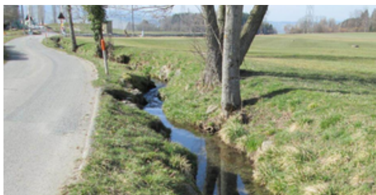
Avant travaux : à la sortie de la canalisation
